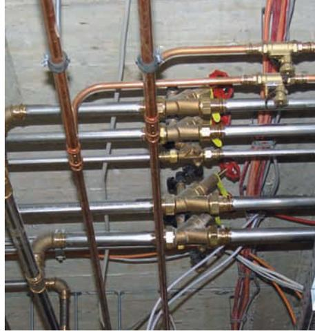
■ Das gesamte Wasserleitungsnetz wird erneuert. Rohre aus Edelstahl sind besonders hygienisch. Um der Gefahr von Krankheitskeimen vorzubeugen, muss das Warmwasser mit einer Temperatur von mindestens 60 °C an der Entnahmestelle ankommen. Dort wird es wegen der Verbrennungsgefahr automatisch auf 45 °C heruntergekühlt.
